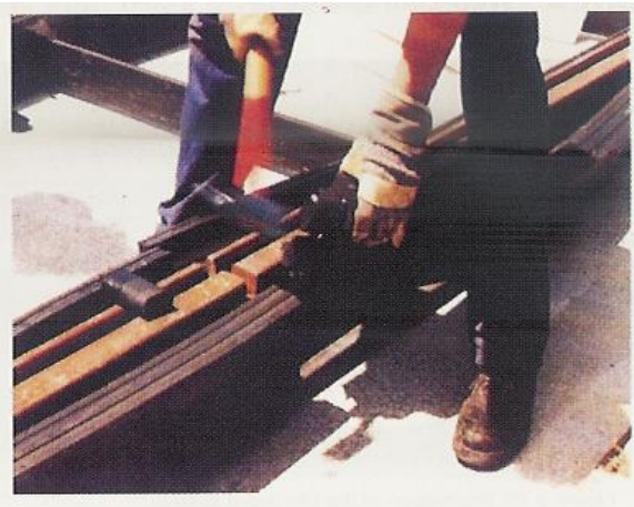
شکل ۲-۳۲ نصب پرکننده‌های جان
