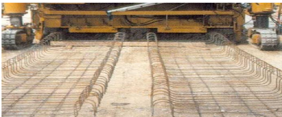
شکل ۲-۱۱ اجرای آرماتور دال بستر سیستم والو
