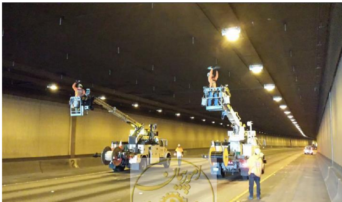
شکل ۷- بازرسی پوشش تونل با استفاده از بالابر
