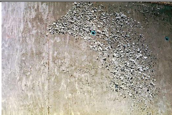
شکل ۴۲→ نمونه بتن لانه زنبوری
