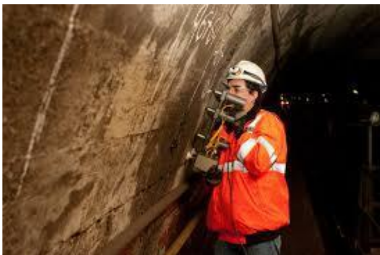
شکل ۴-۱ انجام مغزه‌گیری از دیوار تونل
