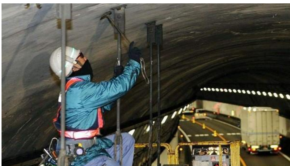
شکل ۱۰-۴ انجام چکش‌زنی بر روی سطوح فوقانی تونل
