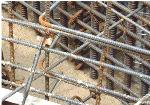
شکل ۵-۱ قابلیت عبور و پر کنندگی SCC در مقطعی با حجم زیاد میلگرد
