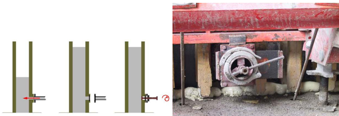
شکل ۲-۷ نحوه بتن‌ریزی دیوار از قسمت پایین قالب
