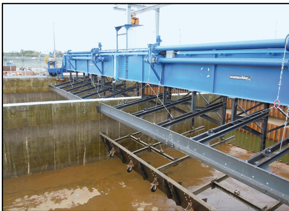
شکل ۴-۱۵- لجن‌روب پارویی با پل رفت و برگشتی ۱
